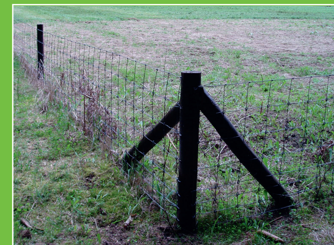
Clôture avec treillis en Ursus et piquets en bois
